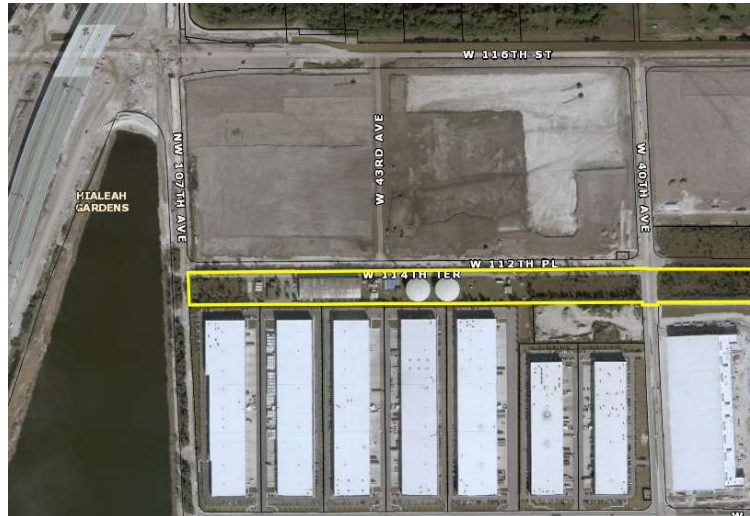
Hialeah RO WTP (Courtesy MDPA)
